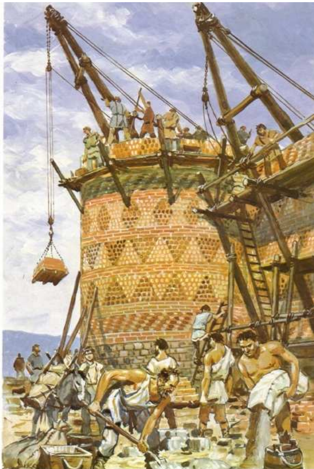
Au Mans, on achève la construction d'un puissant rempart de briques et de pierres, comportant de nombreuses tours semi-circulaires. Les matériaux sont hissés à l'aide d'appareils de levage, appelés « chèvres ». La ville pourra désormais résister à l'assaut d'éventuels Barbares.
